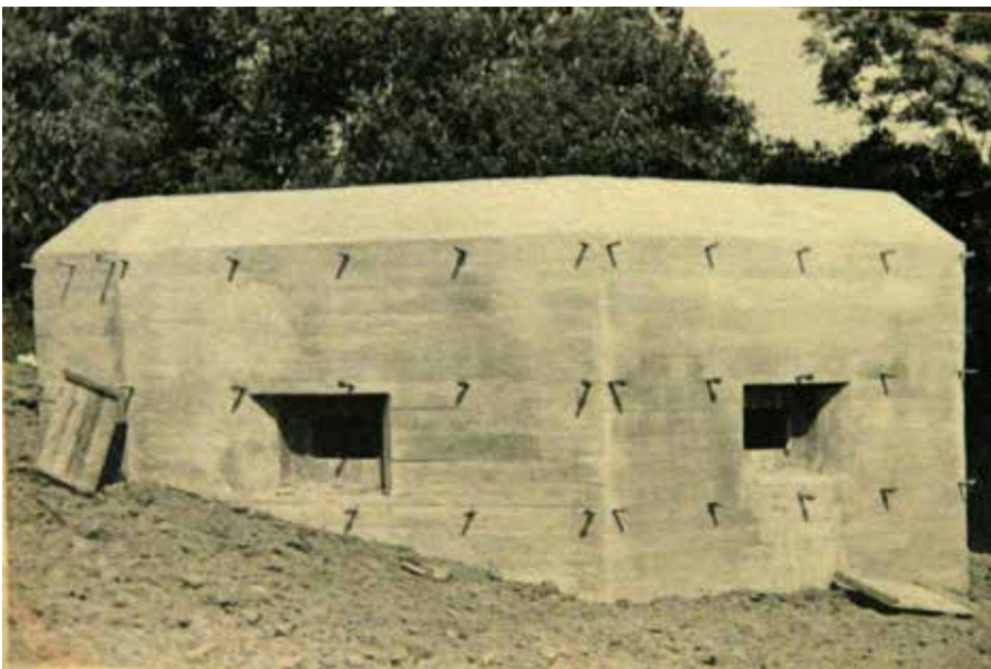
De bunker, stekelvarken, gloednieuw.
