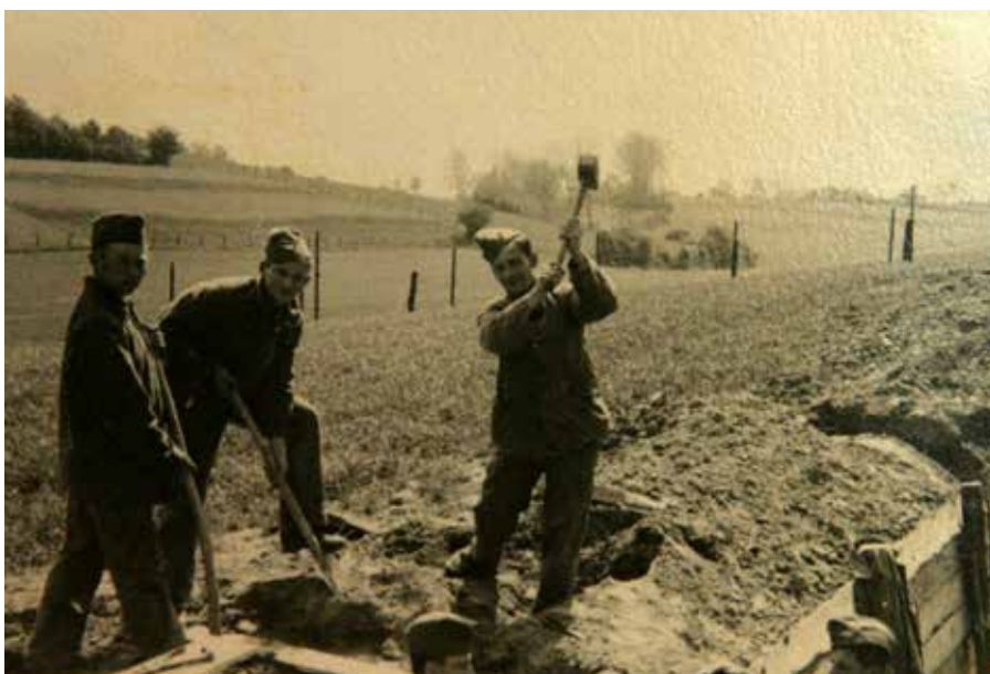
Aanleggen van de loopgraven.
